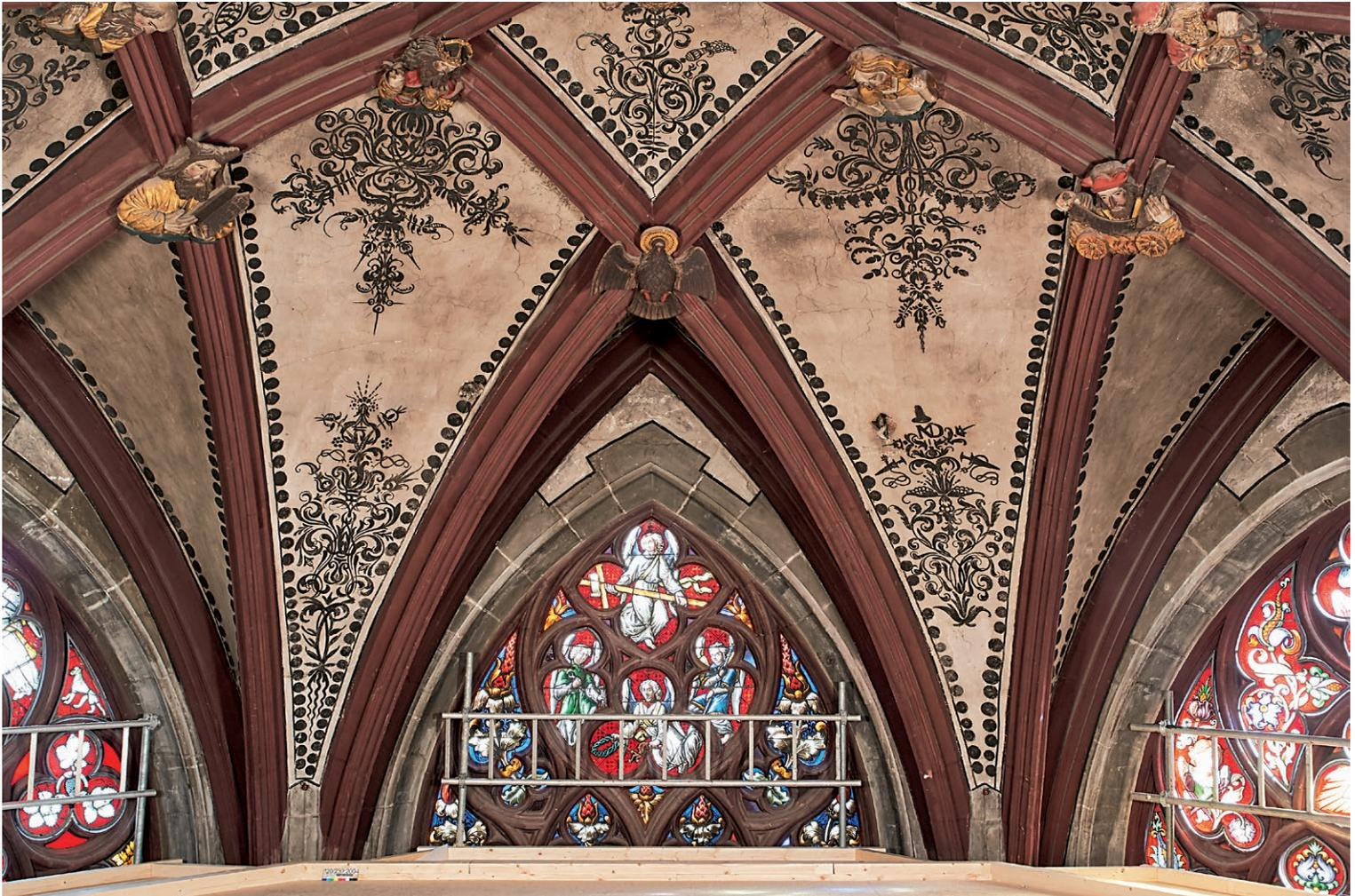
besondere Herausforderung dar. Nach einer ersten Kartierung des Gewölbes, mittels einer hochauflösenden Fotoaufnahme, wurde deutlich, dass nicht Schäden, sondern eine überaus starke, seit Jahrhunderten gewachsene Verschmutzung das Hauptproblem war. Diese Verschmutzung verunklärte das Erscheinungsbild nachhaltig. Die ehemals weissen Kappenflächen erschienen in dunklem Grau und die Farbigkeit der Büsten liess sich nur stark gedämpft erahnen.
