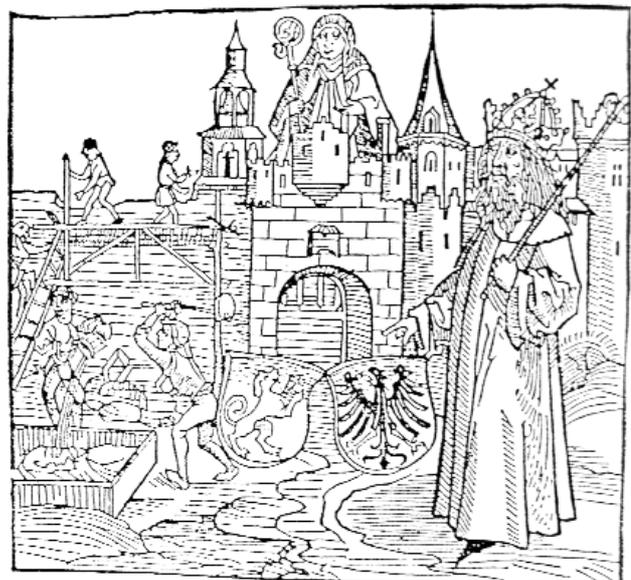
**Abb. 6:** Ein Mörtelmacher holt zu einem kräftigen Schlag mit der Mörtelhacke aus um den Mörtel im Mörtelkasten aufzulockern und zu mischen, ein Knecht gibt Anmachwasser dazu, 1492.
