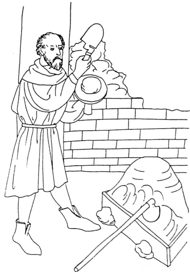
**Abb. 9:** Ein Verputzer oder Gipser beim Verputzen einer Wandfläche mit Mörtelbrett und Kelle vor einem Mörtelkasten mit Haufwerk und Mörtelhacke 1425–36.
