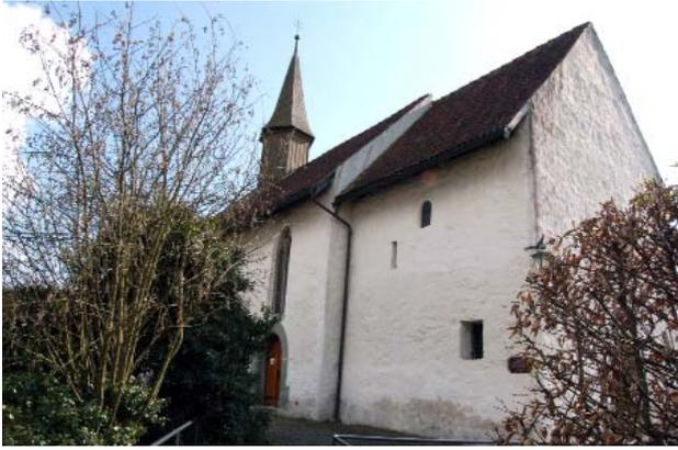
**Abb. 14: Aussenfassade der Silvesterkapelle in Goldbach. Schäden im Sockelbereich nach Neuverputz mit Saniermörtel. Die neuen Schäden traten bereits nach wenigern Jahren wieder auf.**
