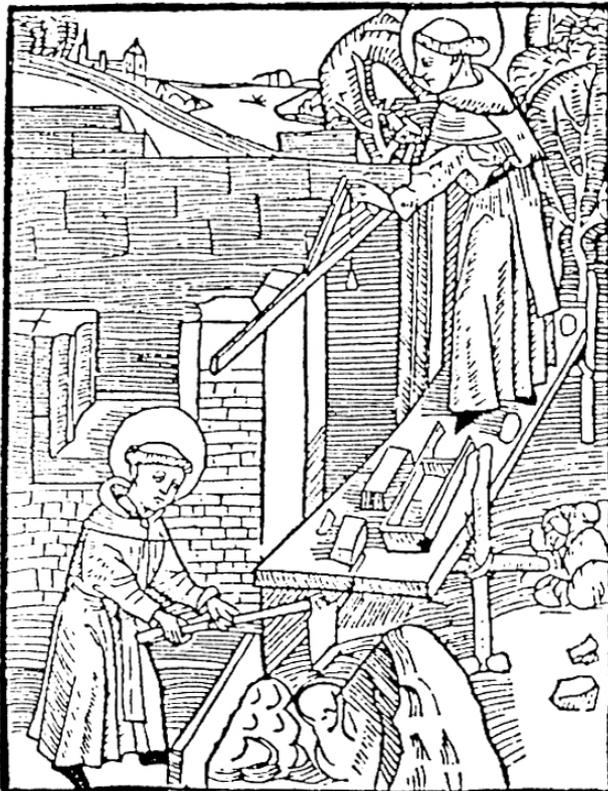
Abb. 1: Mörtelmacher mit Mörtelhacke vor einem Haufwerk. Als Anschlag dient nur ein Brett, es existiert kein geschlossener Mörtelkasten, 1496.
