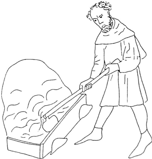
**Abb. 7:** Der Mörtelmacher mit der Hacke vor einem Mörtelkasten beim Mischen, 1425–36.
