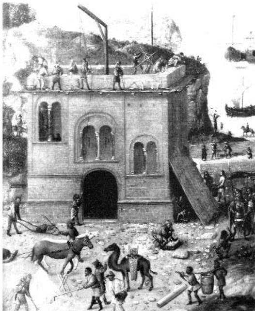
**Abb. 5:** Großes Haufwerk ohne Mörtelkasten, die Mörtelmacher hacken mit langstieligen Hacken den Mörtel fein, 1480.
