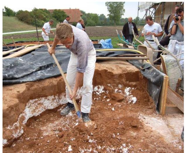
Abb. 11: Modernes Haufwerk im Mörtelkasten, angelegt während des Mörtelseminars im Sommer 2008.
