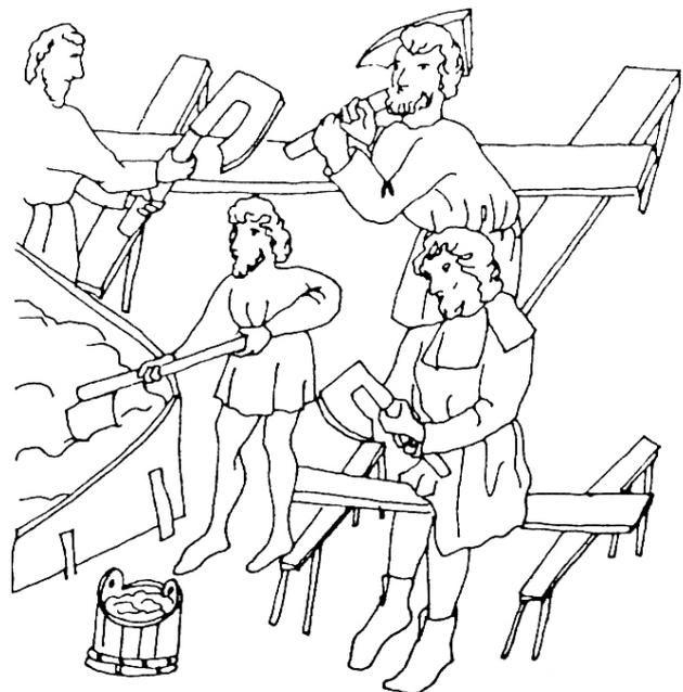
Abb. 2: Mörtelmacher mit Mörtelhacke vor einem grossem Haufwerk in geschlossenem Mörtelkasten. Im Vordergrund ein Bottich mit Anmachwasser, 1460.
