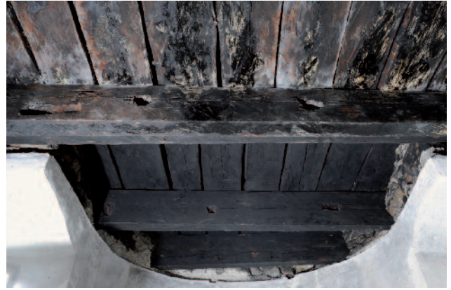
7 Übersicht zu Ausnehmung an Balken mit bisher unbekannter Funktion an der Bal- ken der Decke über der Apsis
