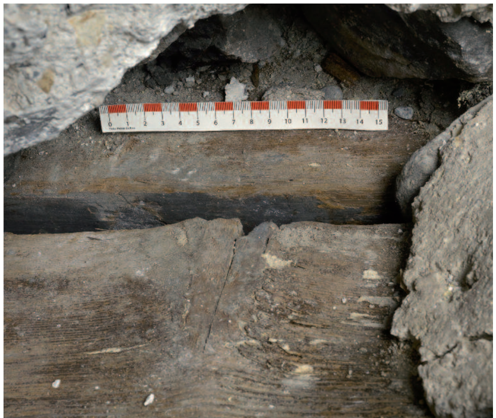
6 Detailansicht einer Deckenbohle von oben mit schwarzem Anstrich
