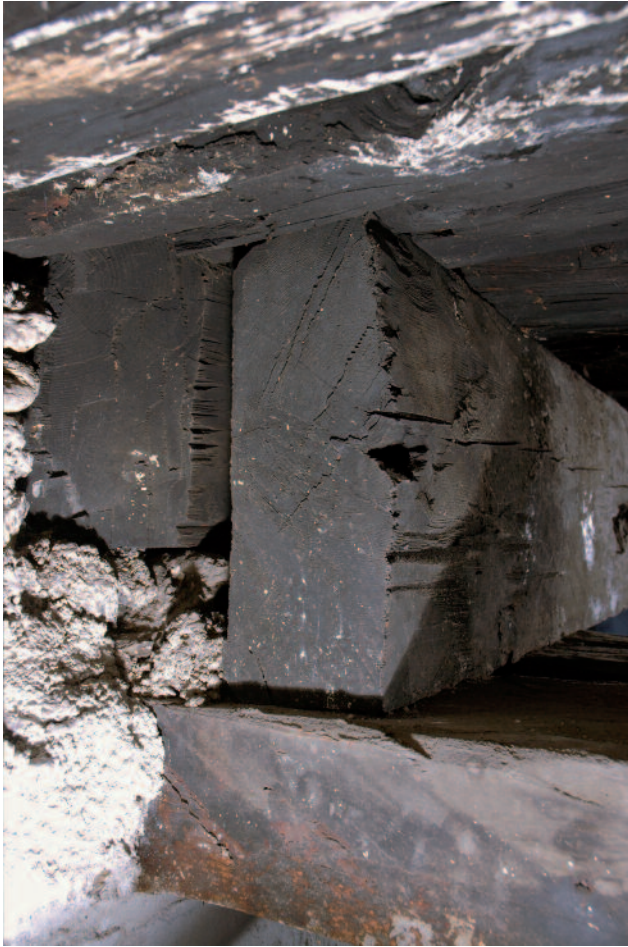
5 Detailansicht der Stirnseiten der Balken mit schwarzem Anstrich
