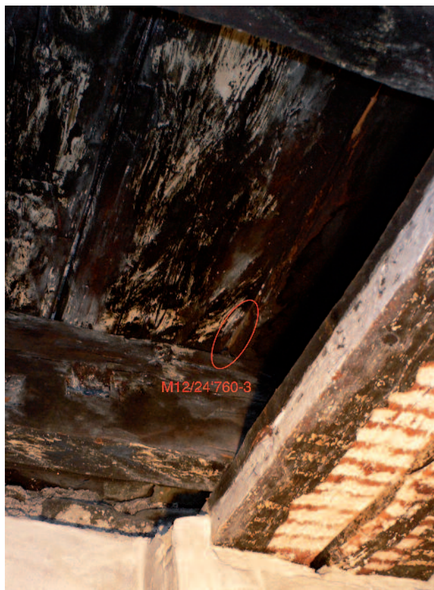
9 Entnahmestelle der Proben von 2012 - 2012 M12/760 an Deckenbohle
