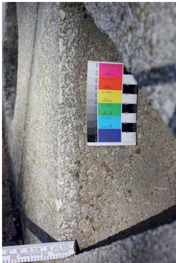
88 Strukturwand „1969“, Detailaufnahme der Vorsatzbetonschicht. Foto: steinfest-Restaurierung GbR, 2021.
